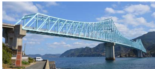
図1 計測対象橋梁（生月大橋，長崎県平戸市）
