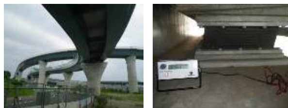
写真-8 E橋での計測状況
