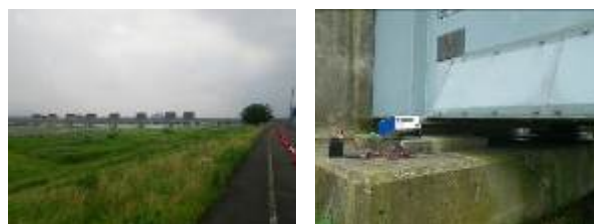
写真-7 D橋での計測状況
