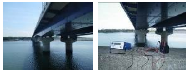
写真-4 A橋での計測状況
