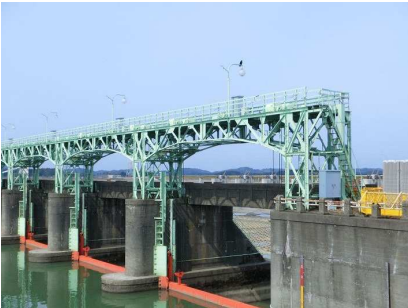
写真1 大河津可動堰 表1 調査内容
