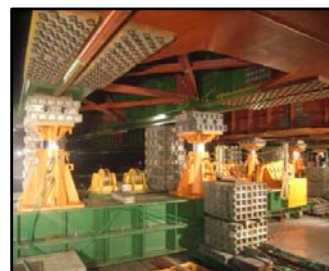
写真-3. 盛替ジャッキ
