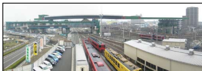
写真-1. 手延機・本橋送出し
