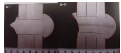
図 1 頭部腐食したリベット継手
