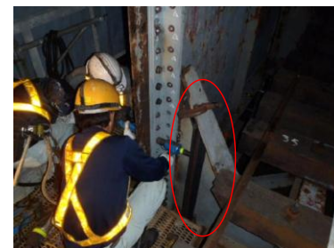
写真 4 鋼材を加工したリベット作業
