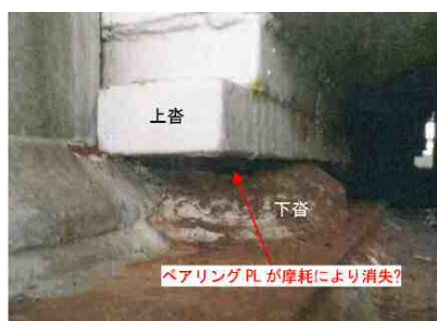
図-1 ゲルバー支承部 (G3桁)
