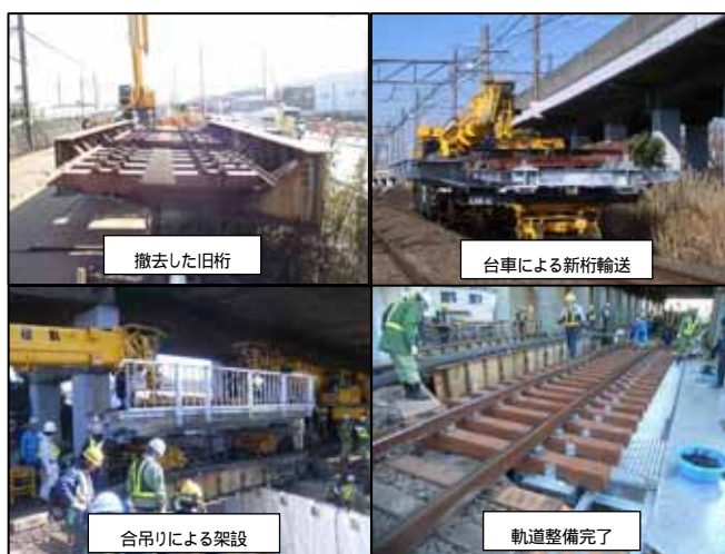
写真-2 施工状況写真
