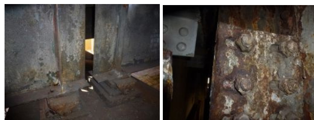
写真-1 桁端部の状況
