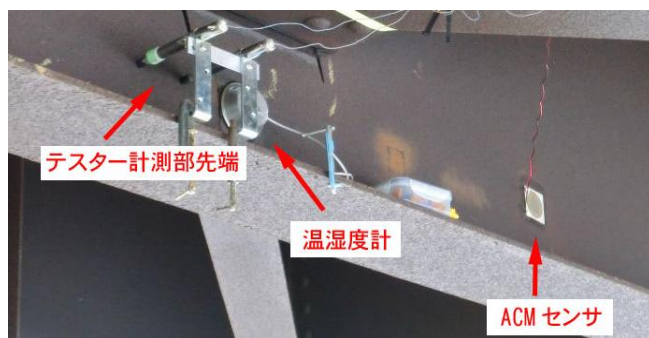
写真-1 機器の設置状況
