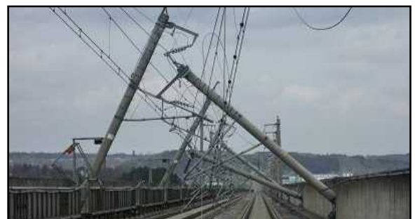
写真-1 折損したコンクリート製電柱
