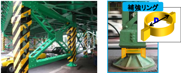
図 2 耐震補強の例
