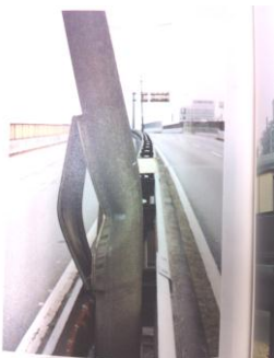
図 1 ポール開口部変形 [5]
