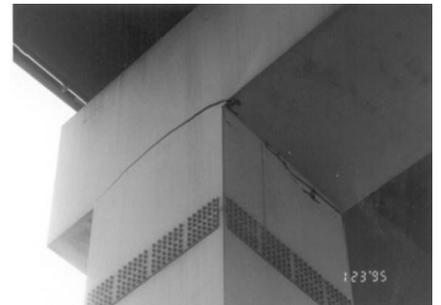
写真-1 地震時脆性破壊発生状況
