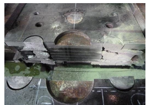
写真-1 支承外面および内部状況
