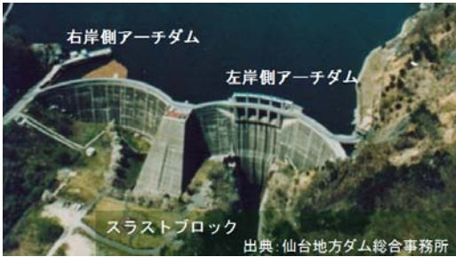
図-1 大倉ダムの全景
