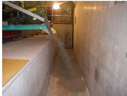
図-4 ベントナイト供給状況 (敷均し機使用)
