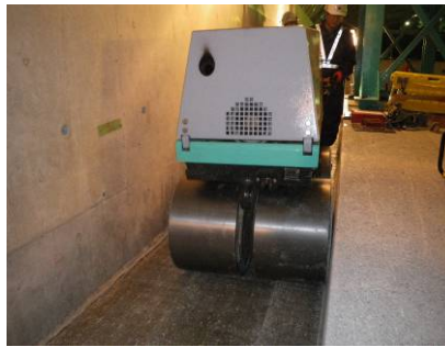
図-6 ベントナイト締固め状況 (小型振動ローラ使用)
