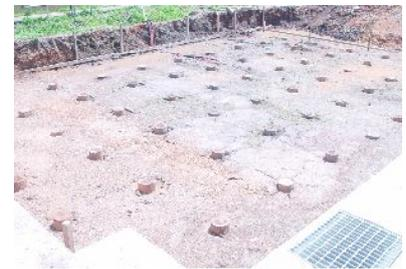
写真-1 丸太杭打設終了状況(A区)
