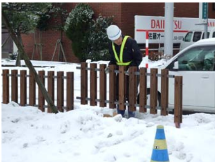
図6 木製防護柵の設置（左、中：ハイブリッドタイプ、右：オールウッドタイプ）
