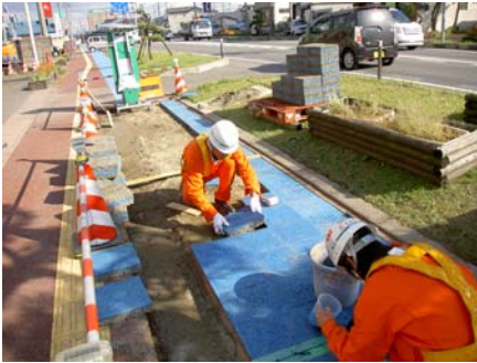
図3 木質平板ブロックの敷設
