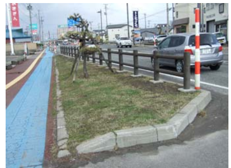
図6 木製防護柵の設置（左、中：ハイブリッドタイプ、右：オールウッドタイプ）
