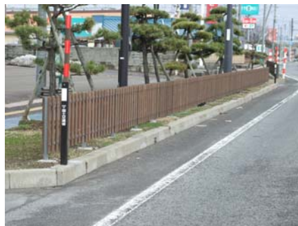
図6 木製防護柵の設置（左、中：ハイブリッドタイプ、右：オールウッドタイプ）
