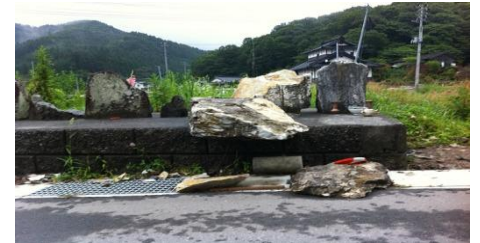
図1. 大船渡市永浜の昭和の津波記念碑 津波で倒壊し放置されている現状(2011年7月)
