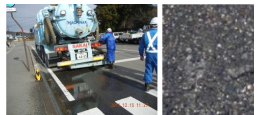
図-6 機能回復車 施工状況
