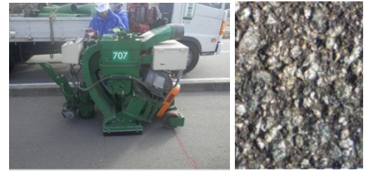
図-4 ショットブラスト 施工状況
