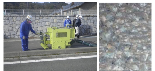
図-3 平削り 施工状況
