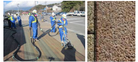
図-5 超高压洗浄 施工状況
