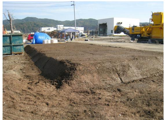
図-4 地盤沈下箇所を嵩上げするために造成した人工地盤
