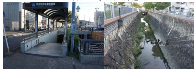
写真-6 東海豪雨で被害にあった野並駅駐輪場出入口と郷下川
