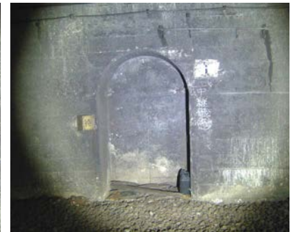
(b) 中継用無線センサの設置状況
