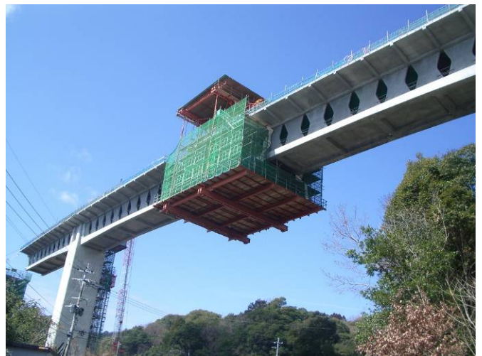
写真-4 田久保川橋の張出し施工状況
