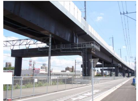
図-1 市街地の在来線上に架設された鋼鉄道橋(連続合成桁)
