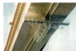
写真-6 点検・作業用ゴンドラの実例
