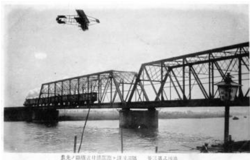
写真-1 土浦線隅田川橋梁
