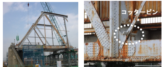
写真-3, 4 解体中の江ヶ崎跨線橋(左)とコッターピン(右)
