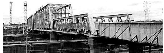
写真-2 新鶴見操車場時代の江ヶ崎跨線橋
