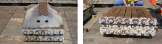
写真-5,6 既設可動支承 (左/全体 右/中層部)
