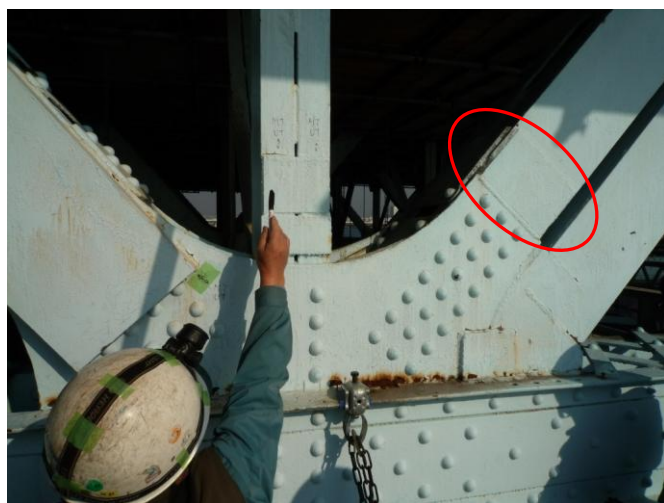
写真 1. 実橋斜材突合せ状況
