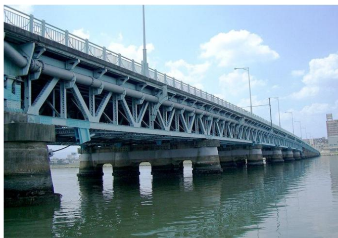
写真 1 対象橋梁外観
