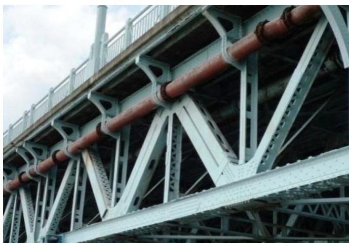
写真 2 トラス主構側面
