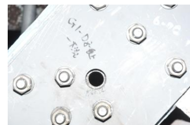
写真4 ビード部確認用搾孔
