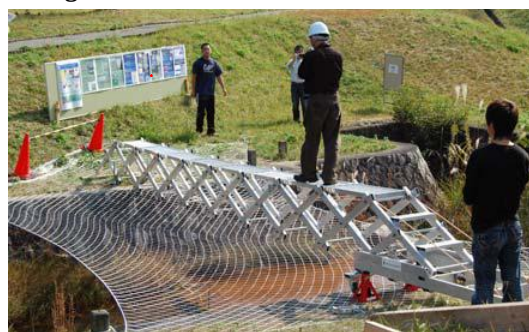
Fig.2 MB 架設後の渡橋の様子
