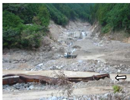
写真-3 流出した道路橋の桁
