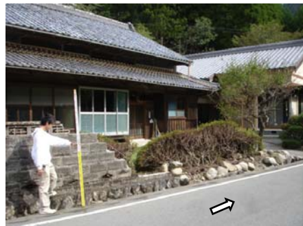
写真-5 土砂ダム上流で壊れた堀
