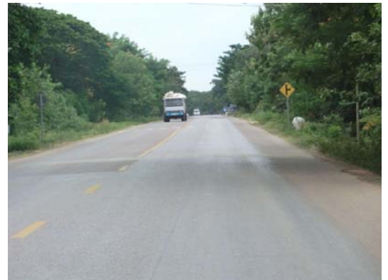
図-1 カンボジア道路舗装 (国道5号線)
