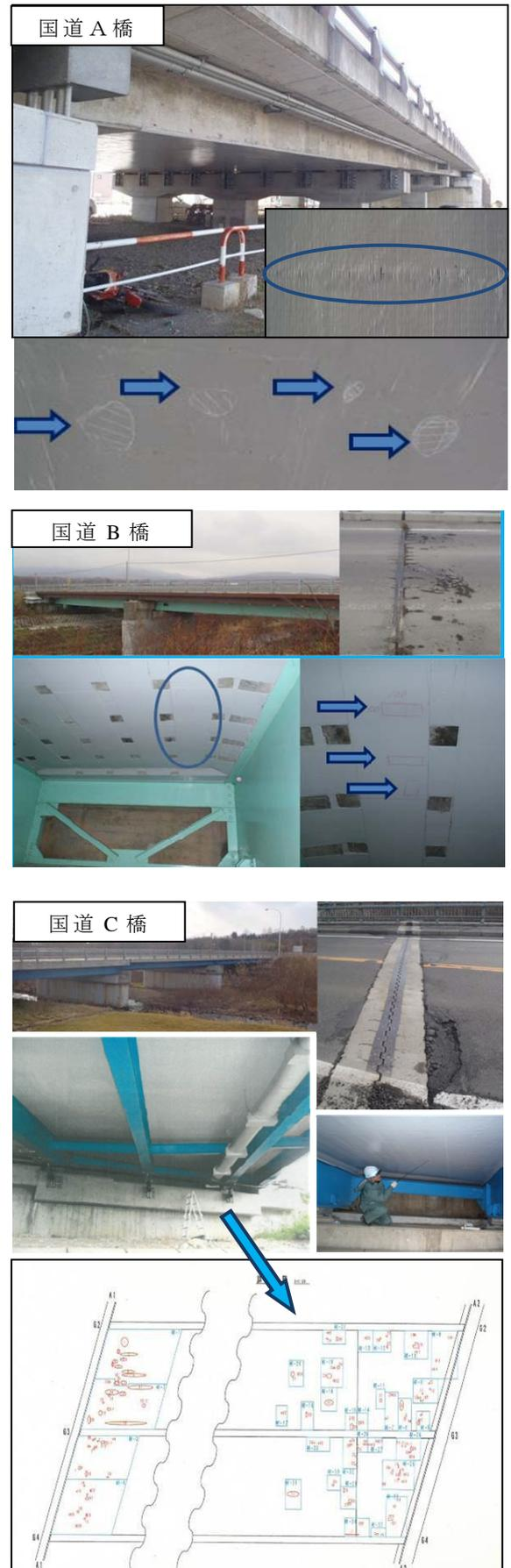
図-4 現地調査により明らかとなった炭素繊維シート補強材の変状事例
