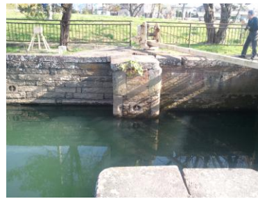
写真-3 石積み・煉瓦積みの状況
