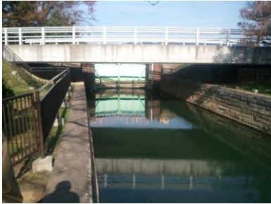
写真-2 石井閘門の状況(平成 23 年 11 月)
