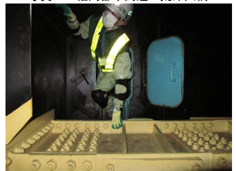
写真-2 箱桁内の移動状況
