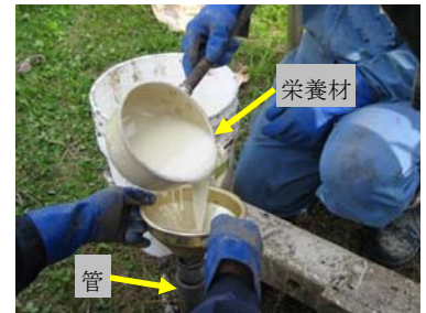
写真-1 栄養材打設状況
