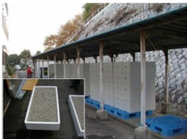
図2 軽石を充填した薄層構造体および傾斜土槽
