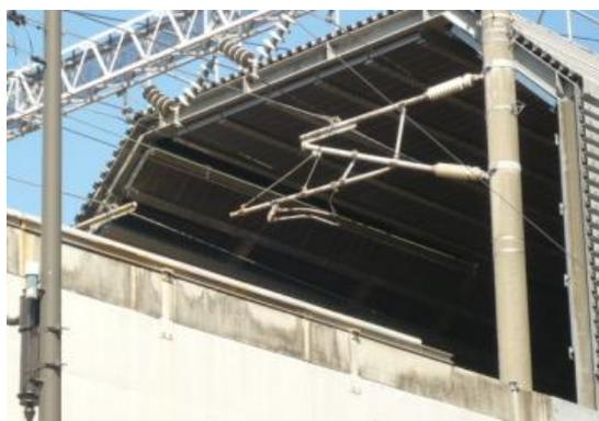
図3 緩衝工内面吸音板設置後の様子
