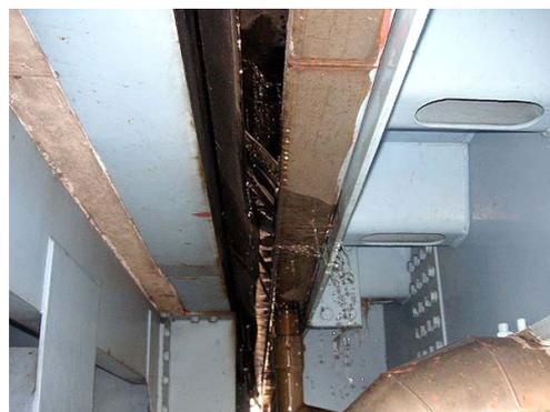
図-1 伸縮装置からの漏水事例
