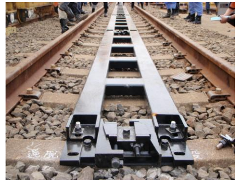
図-1 逸脱防止ガード敷設状況
