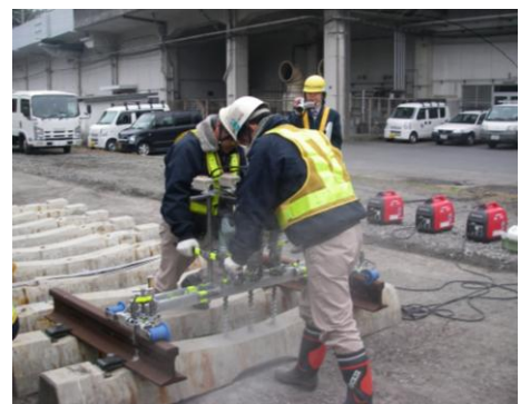
図-2 試作機による施工状況
