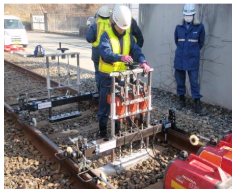
図-3 量産機による施工状況
