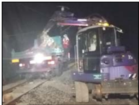
写真-1 載線軌陸車への道床バラスト積込み
