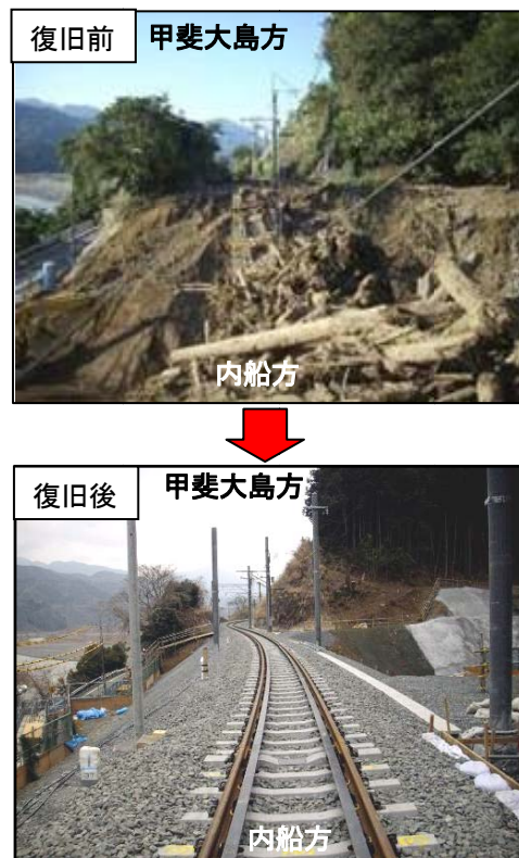
写真-2 盛土崩壊箇所の復旧前後
