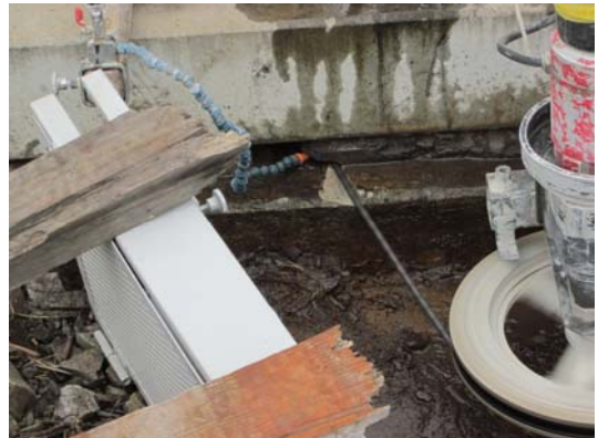
図-7 ワイヤソーによるてん充層の切断状況②
