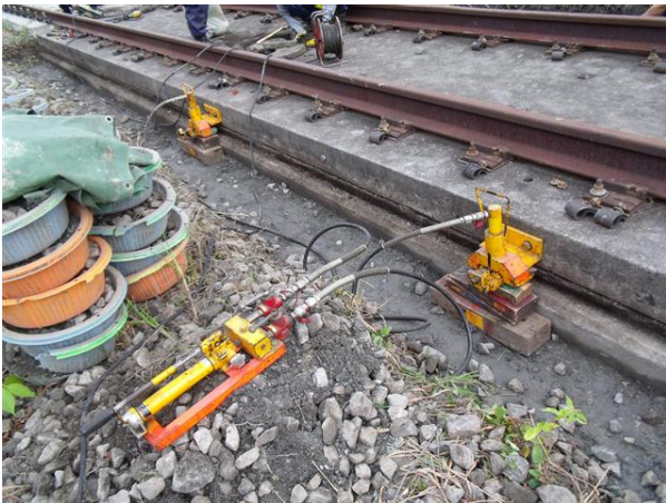
図-1 スラブジャッキによるこう上
