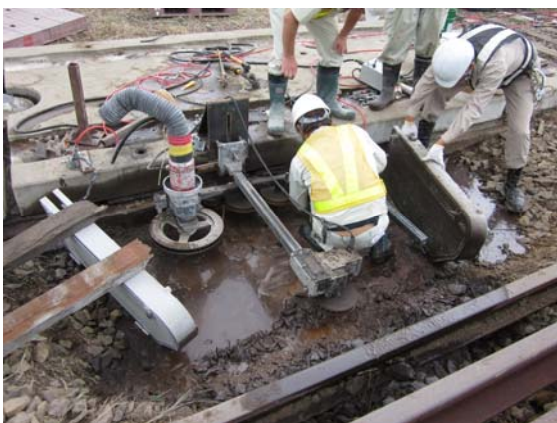
図-6 ワイヤソーによるてん充層の切断状況①
