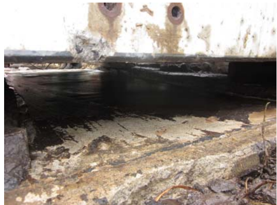
図-8 CAMを切断撤去した路盤コンクリート
