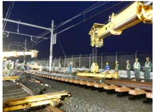
図5 252イ分岐器ポイント部横移動
