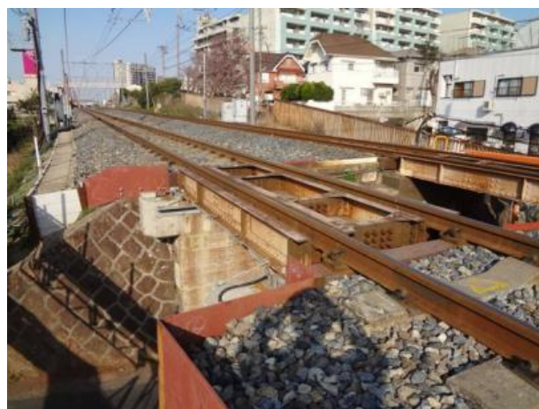
写真-2 畑橋りょう（移設後）
