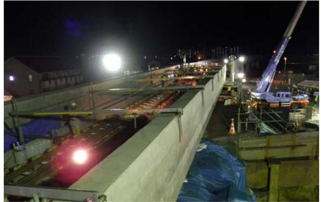
写真-1 県道下路桁横取り状況
