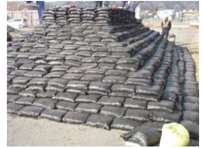
写真 2 ソルパック試験施工
