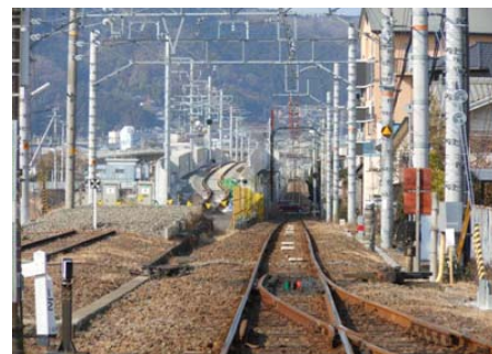
写真1 富士方線路切換点
