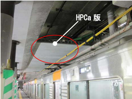
写真-1 HPCa 版架設状況
