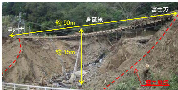
写真-1 盛土崩壊状況
