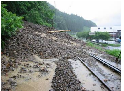
図 2 H18 大崩沢橋りょう 土砂流入
