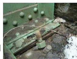
写真-4 沓座アンカー
