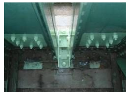
写真-7 桁間隔保持材設置
