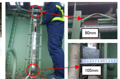
写真-5 1連目桁・2連目桁 間隔縮小状況
