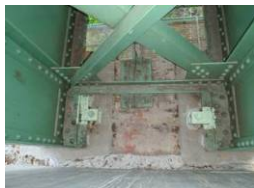
写真-6 新規アンカーボルト打設
